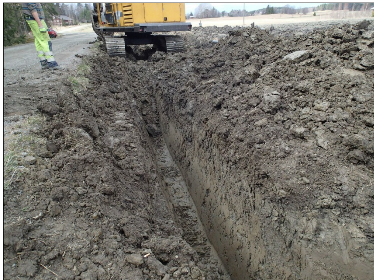
Kaivettua linjaa, jossa ei kulttuurikerrosta eikä rakenteita.
